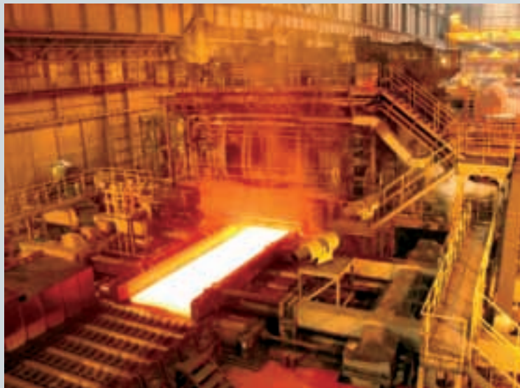
提供给东国钢铁有限公司唐津厂的宽厚板轧机
