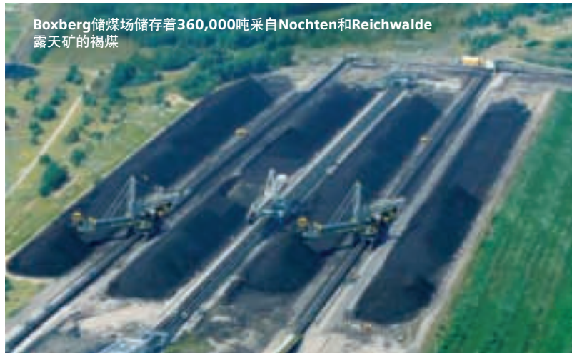
Boxberg电厂的总装机容量为1,900 MW
