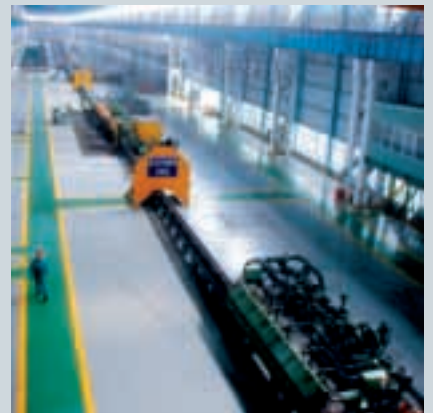
西门子奥钢联提供的线材轧制生产线
