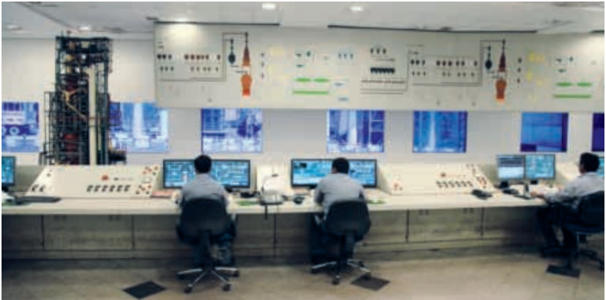
上：热带钢轧机。下：JSW钢铁公司Toranagallu厂(粗钢额定产能2,400吨/日)两套Corex设备的控制室
